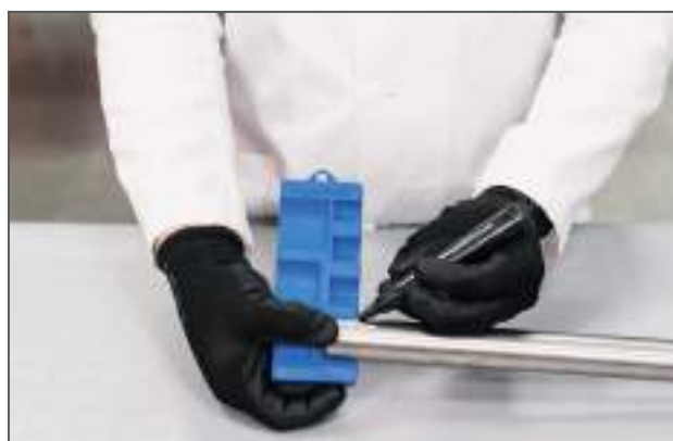
Marcatura della profondità d'innesto / Marking the insertion depth
